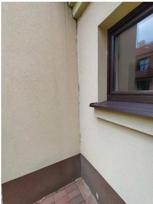
Fot. 11 Pęknięcia w narożu hali i łącznika.
