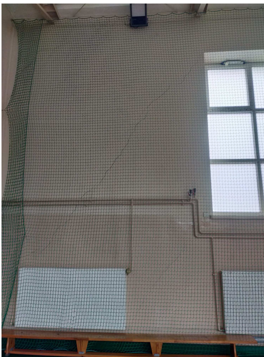
Fot. 6 Pęknięcie biegnące od południowo-wschodniego narożnika hali do nadproża oraz kolejna rysa do parapetu okna.
