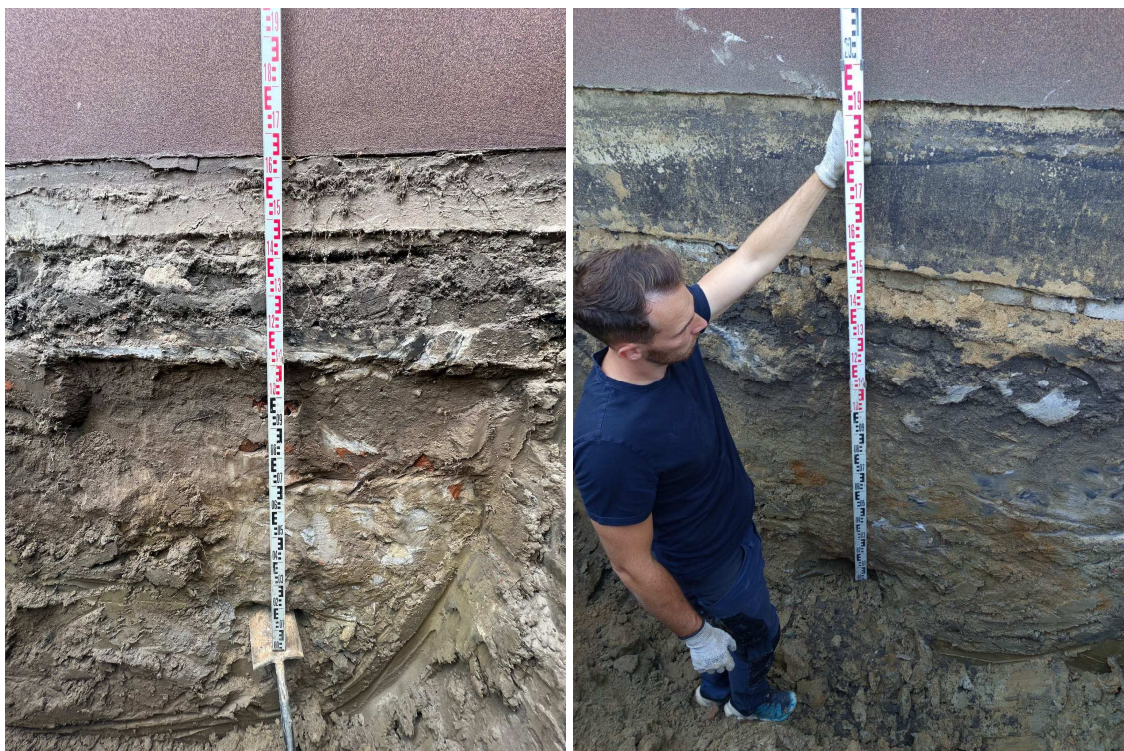
Fot. 18 Widok fundamentów w odkrywkach: z lewej OD-1, z prawej OD-8.
