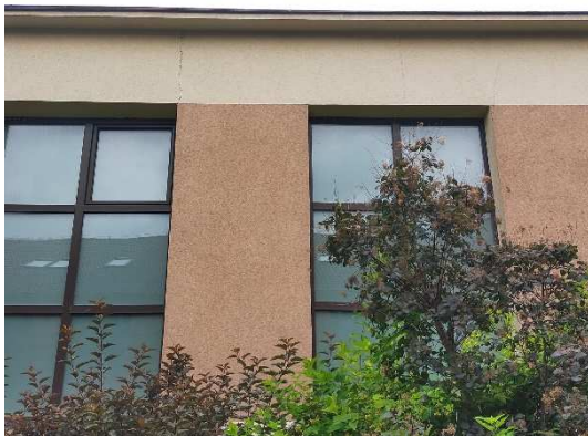
Fot. 14 Rysy od nadproży biegnące do dachu.
