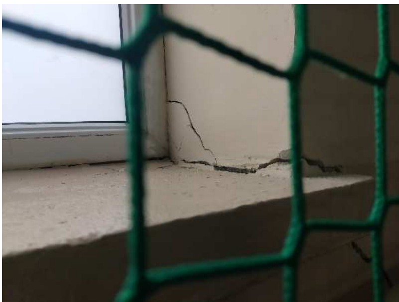
Fot. 8 Pęknięcia poziome.
