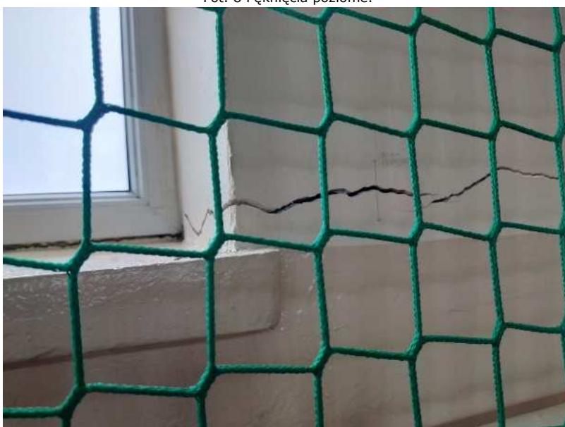
Fot. 9 Pęknięcia poziome.
