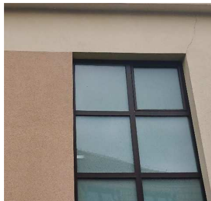
Fot. 15 Rysy od nadproży biegnące do dachu.
