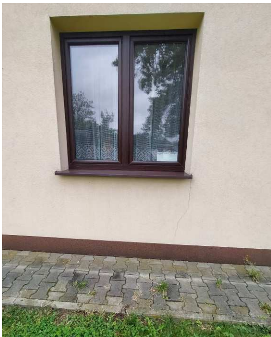
Fot. 16 Rysy przy parapecie (ściana zachodnia).
