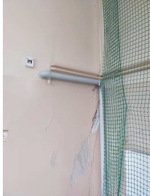
Fot. 5 Pęknięcie i odspojenie tynku w narożu hali sportowej przy łączniku.
